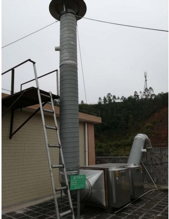
备用发电机尾气排气筒
